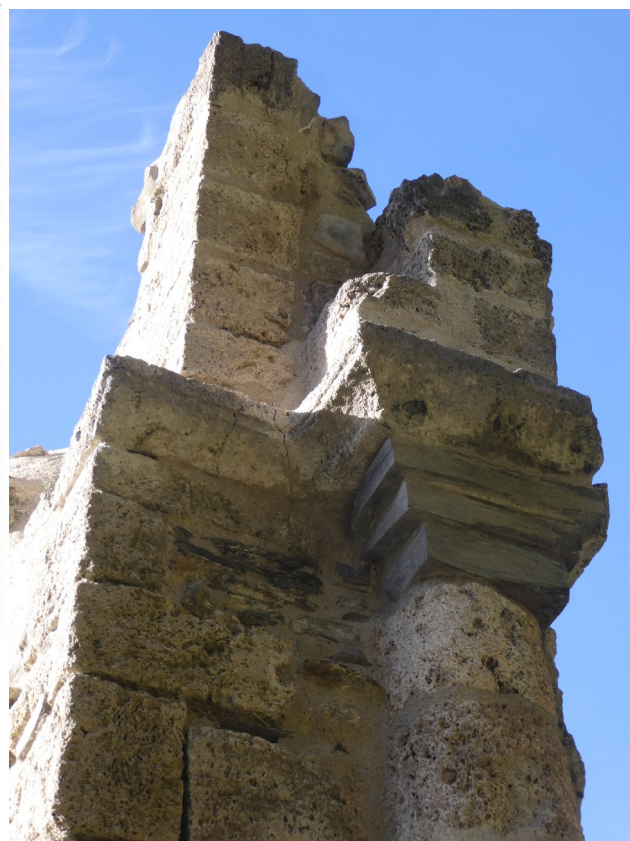
Ci dessous deux claveaux sont tombés et le troisième est en équilibre instable prêt à tomber
