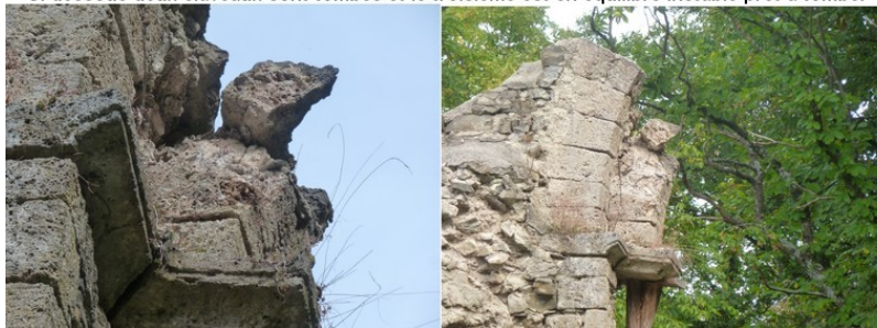
Ci dessous deux claveaux sont tombés et le troisième est en équilibre instable prêt à tomber
